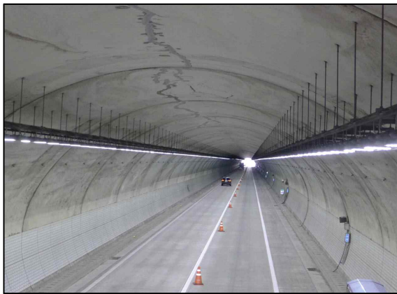
c. 천단부 상태양호(누수 없음)
