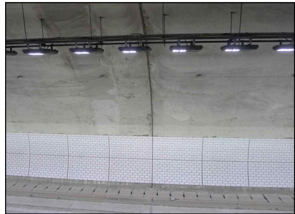
d. 측벽부 타일 시공현황
