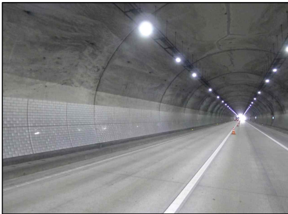
c. 콘크리트 라이닝(측벽부) 전경
