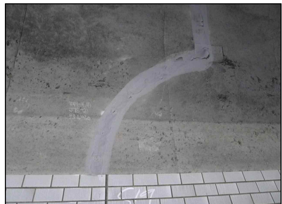
b. 측벽부 S19 균열 보수현황
