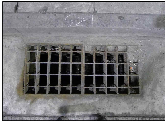
d. 배수시설 상태양호
