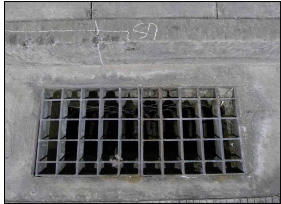
b. 배수시설 집수구 전경
