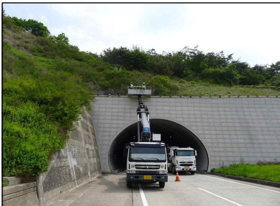
c. 고소작업차량을 이용한 갱구부 외관조사현황
