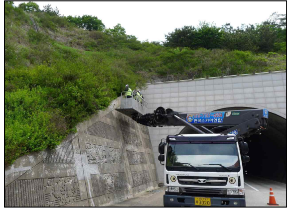
b. 갱구부 옹벽 외관조사 현황
