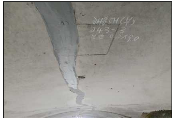
h. 천단부 S43 균열 보수현황
