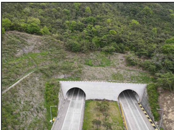
a. 시점부 사면 전경
