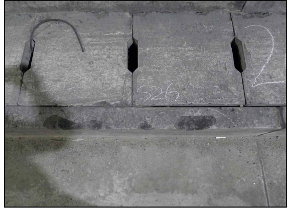
b. 공동구 덮개 설치현황
