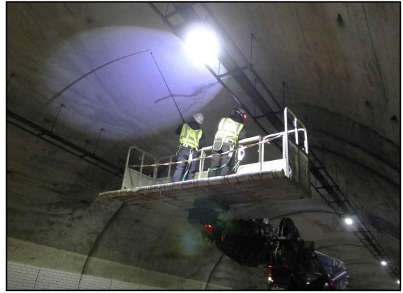
b. 고소작업차량을 이용한 천단부 외관조사현황
