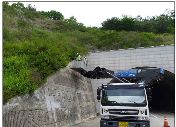
d. 고소작업차량을 이용한 옹벽 외관조사현황
