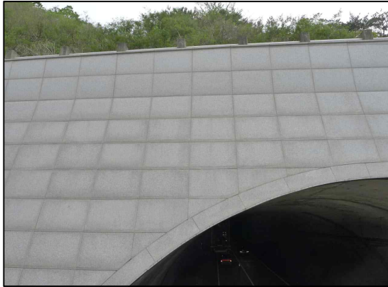
a. 시점 갯문 면벽 상태양호
