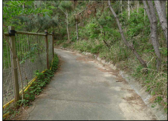
b. 종점부 사면 소단 배수로
