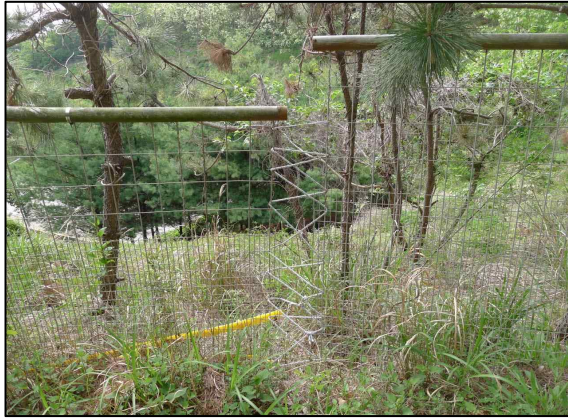
c. 종점부 휨스 파손
