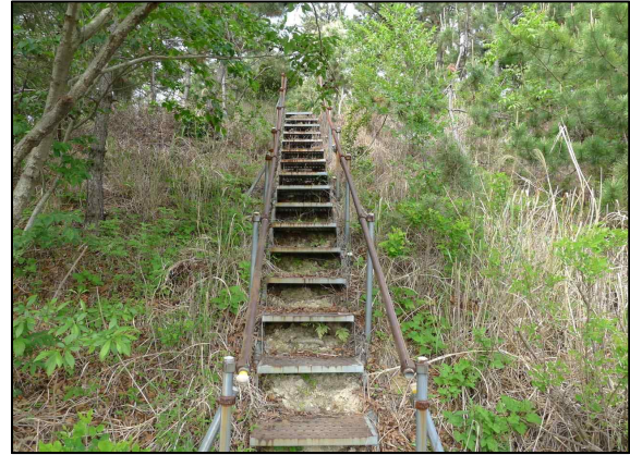
d. 사면 내 점검계단 설치현황
