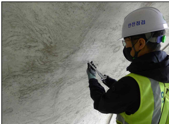
c. 탄산화깊이 측정현황
