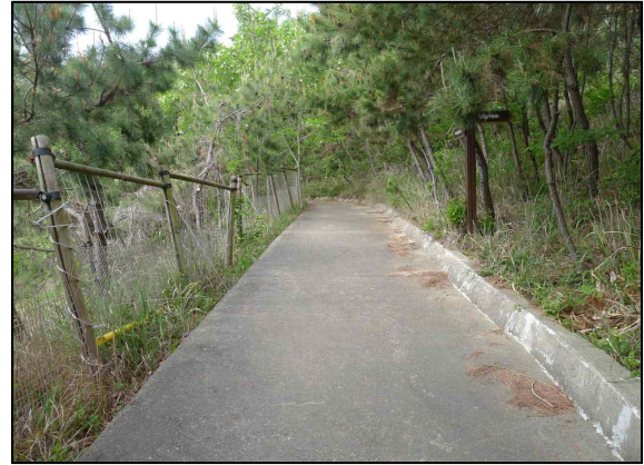
b. 중점부 사면 소단 배수로 상태양호
