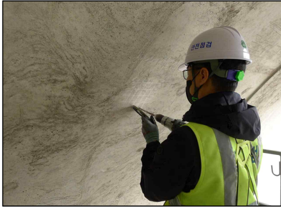
a. 탄산화시험부 부재 천공 현황
