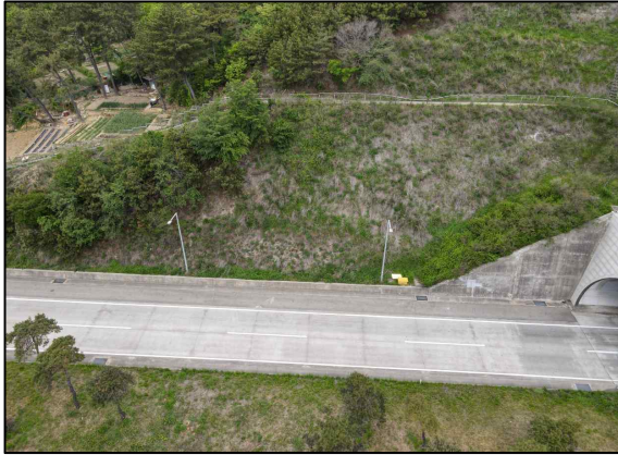
c. 시점부 사면 표면보호공(식생공) 시공현황
