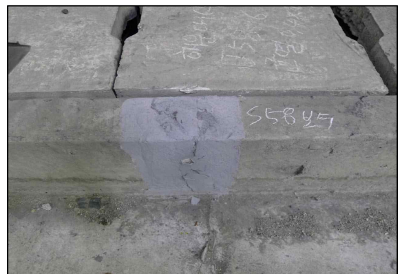
f. 공동구 S58 균열 보수현황
