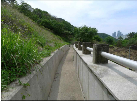
a. 시점 갱구부 상단 배수로 전경
